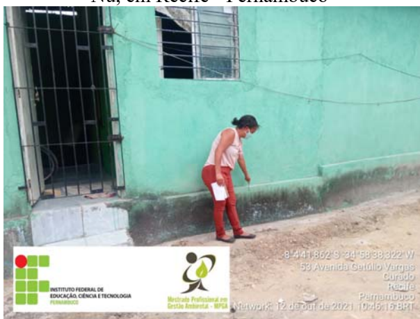
Figura 36 - Marca do nível da água durante chuva intensa em Tejipió na Comunidade Sapo Nu, em Recife - Pernambuco
