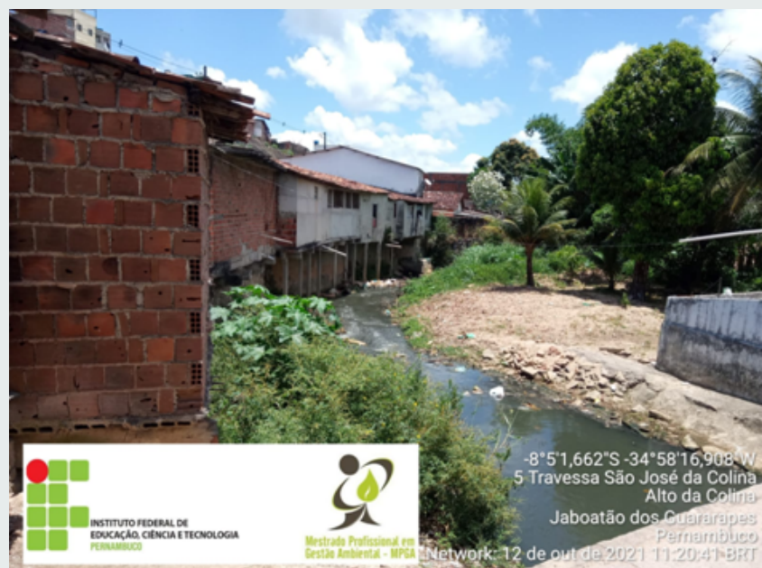
Figura 5 – Bairro Alto das Colinas, em Jaboatão dos Guararapes - Pernambuco
