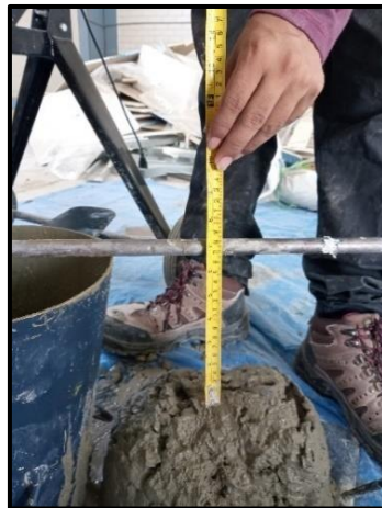
Medición del asentamiento en el Cono de Abrams
