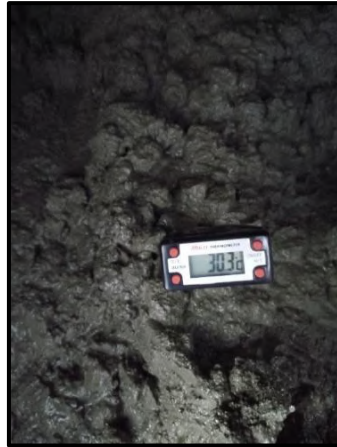
Medición de temperatura en la mezcla de concreto fresco
