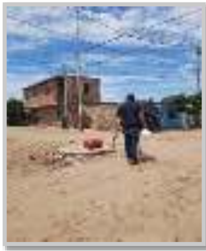
Figura 4.23: Evidencia levantamiento topográfico - 2
