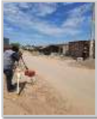
Figura 4.22: Evidencia levantamiento topográfico - 1
