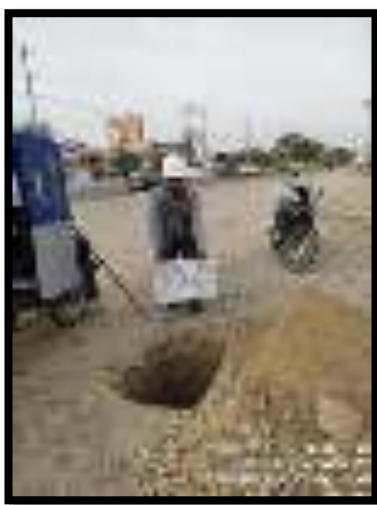
Figura 3.2: Calicata N°1 – Calle José de Lama
