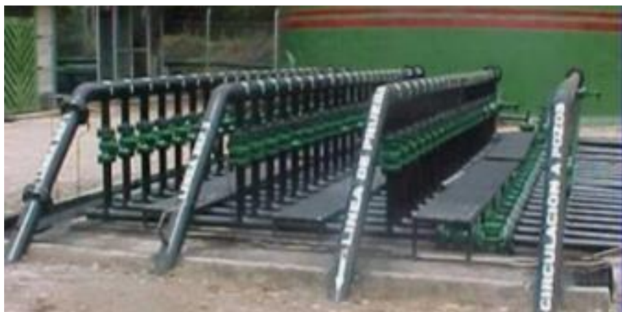
Figura N° 15 Manifold
