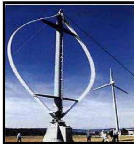
**Figura 24 - Aerogenerador Darrieus**
