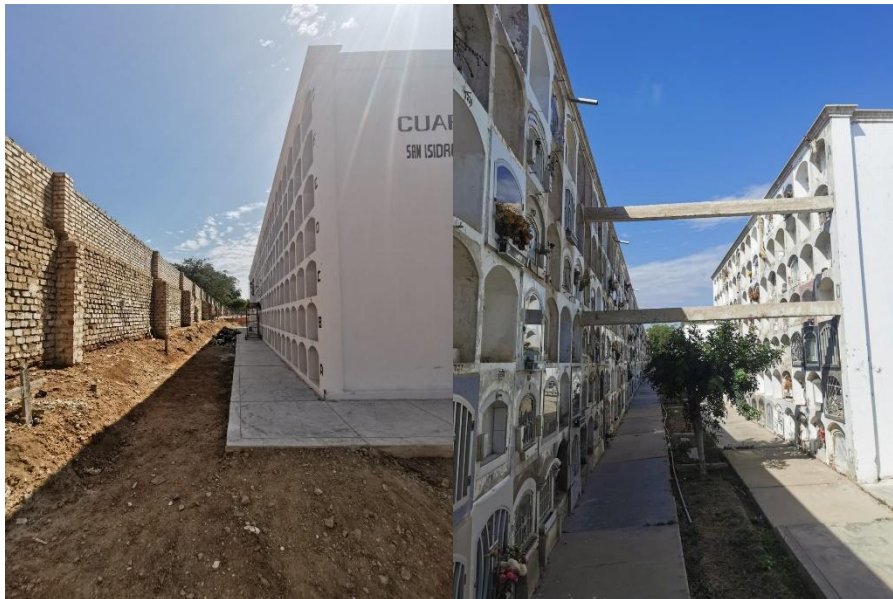
Figura 30. Construcción de nuevo cuartel Sa Isidro Labrador, muy cerca del borde perimétrico. Figura 31. Pabellones en mal estado. Elaboración Propia.
