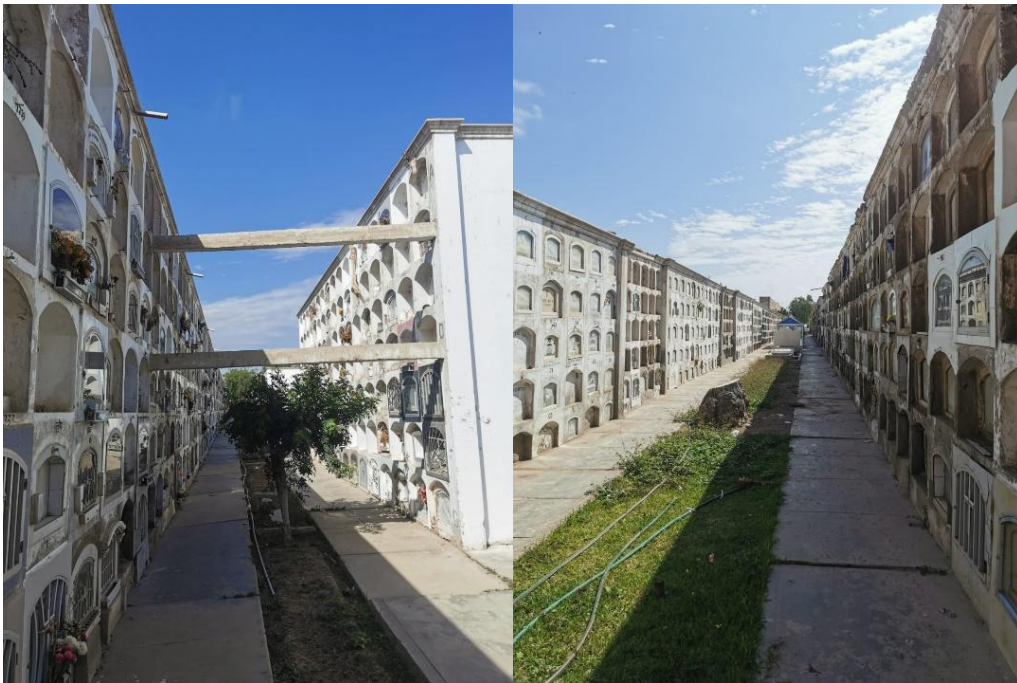
Figura 14. Cementerio Público “El Carmen”, saturación y mal diseño. Elaboración propia.
