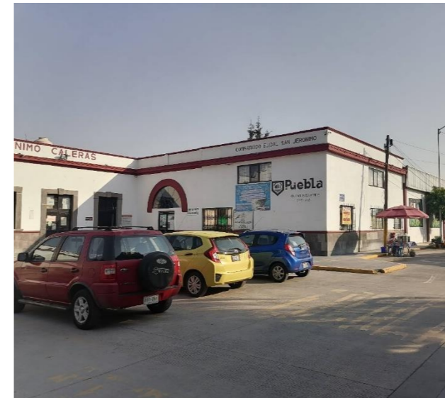
Fig. 48. Salón de usos múltiples acceso principal (Marco Ventura, 2020).
