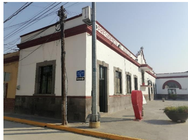
Fig. 29. Conexión eléctrica municipal (Marco Ventura, 2020).
