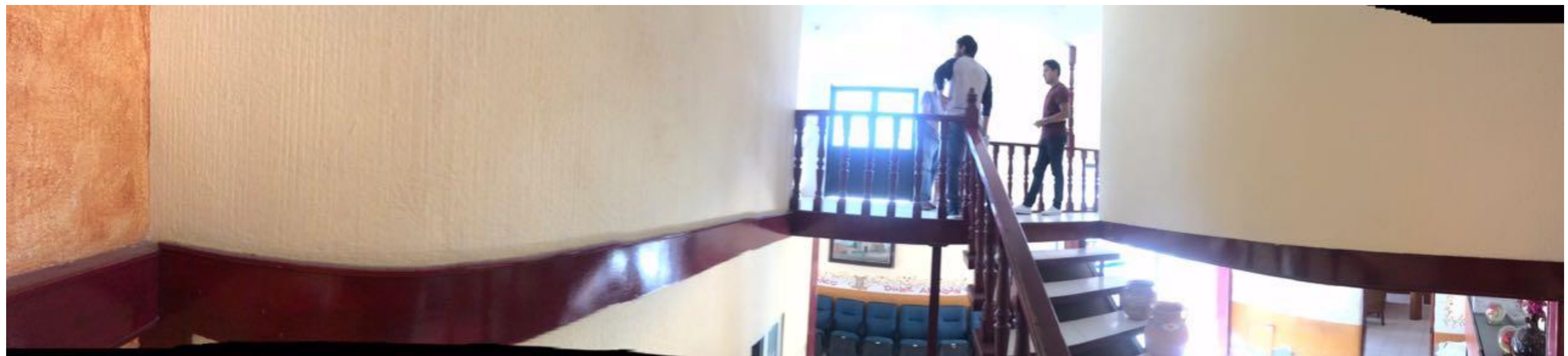
Fig. 63. Muros divisorios de Tablaroca (Eduardo Barroso, 2020).
