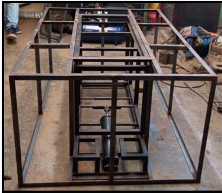
Figura 24 Proceso de construcción de la estructura fija
