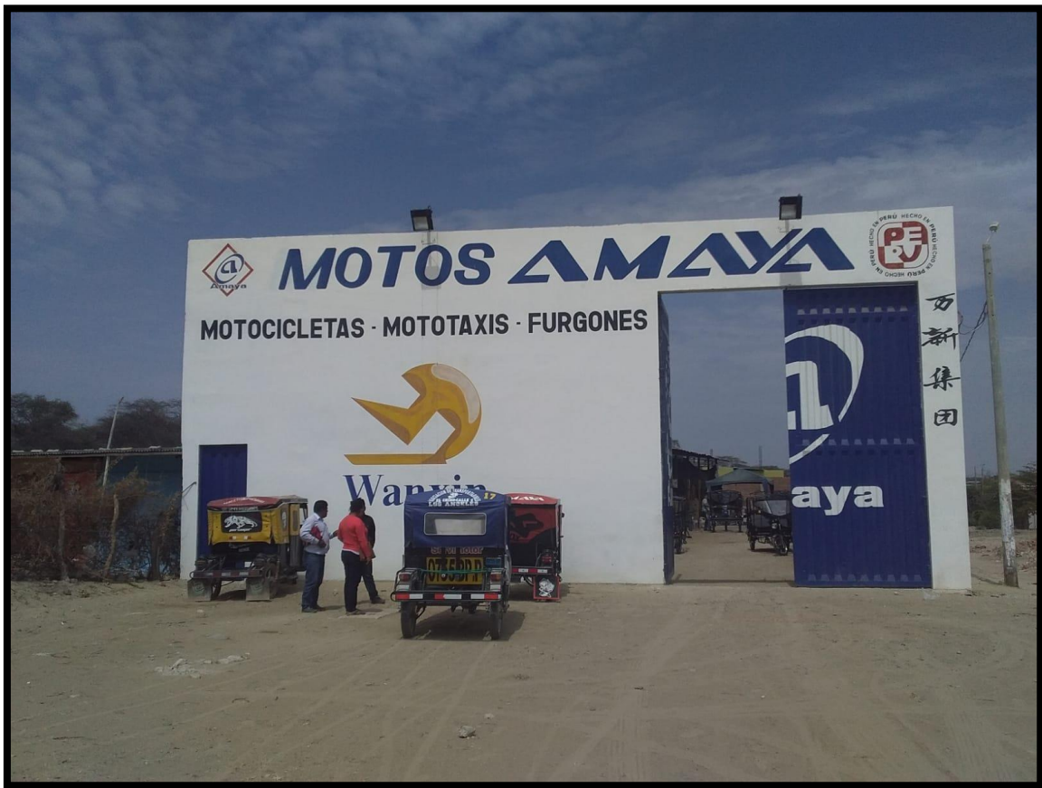
ANEXO 10. Fotografía de la planta industrial de la empresa Motos Amaya E.I.R.L.
