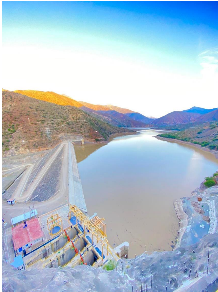
Figura 27. Vista Panorámica de la presa “LIMÓN”, Concesionaria Trasvase Olmos.
