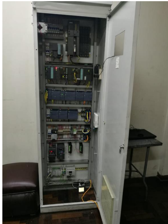
Figura 104: Módulos PLC S71200, utilizados para la demostración del proyecto de tesis.
