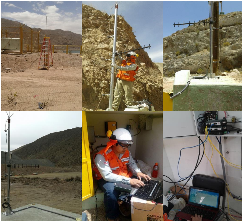
Figura 108. Toma Fotográfica de ubicación, direccionamiento de antenas y configuración de radio módems; pruebas de comunicación.
