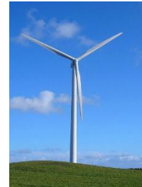
Gambar 2.4. Turbin Angin Sumbu Horizontal (Olson dan Visser, 2008)
