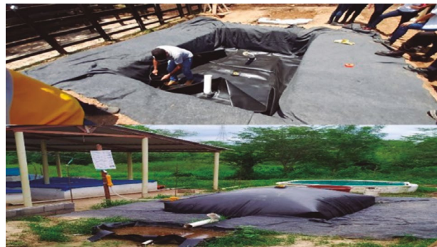
Figura 5. Área de construcción del biodigestor.
