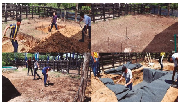
Figura 3. Procesos constructivos del biodigestor.
