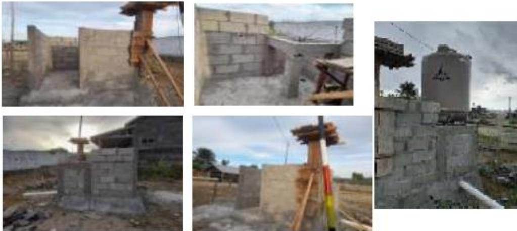
Gambar 7 Pembuatan kamar mandi, pemasanganudukan tandon air, dan tangki penyaring air minum.
