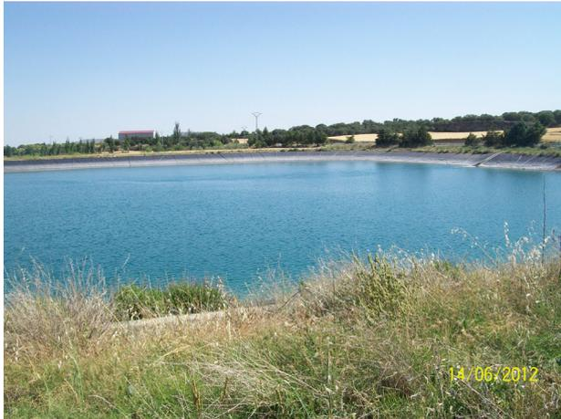
Figura 11. La modernización de Riegos del Alto Aragón ha conducido a la construcción de balsas que permiten incrementar las reservas internas de agua y favorecen el riego por aspersión, aunque obligan a un mayor consumo de energía. Además, las balsas dan lugar a una mayor flexibilidad en el uso del agua por parte de los regantes. En la imagen, balsa de Peraltilla.
