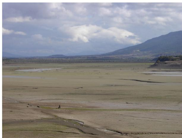
Figura 5. Acumulación de sedimentos en el embalse de Yesa, en el río Aragón. Este fenómeno afecta con igual intensidad a los embalses que abastecen a Riegos del Alto Aragón, especialmente el de Mediano en el río Cinca.
