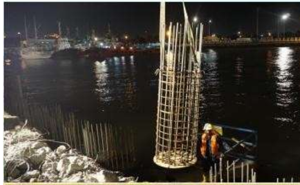
Gambar 4.14. Proses Instalasi Pembesian Pancang
