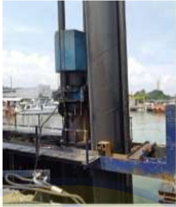
Gambar 4.10. Pemancangan Dengan Hammer
