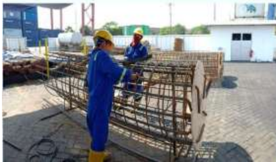
Gambar 4.12. Pabrikasi besi isian pancang
