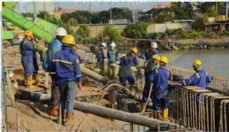
Gambar 4.31. Pengecoran capping beam tahap 1
