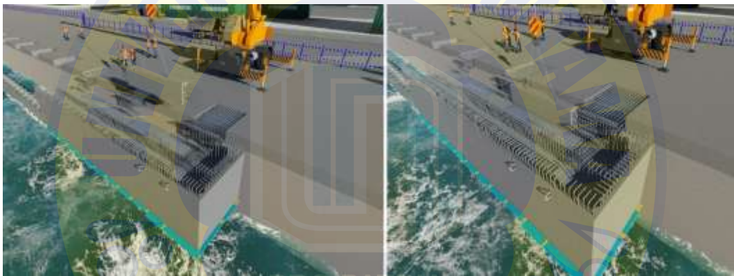
Gambar 4.29. Visualisasi Pemasangan Precast PB
