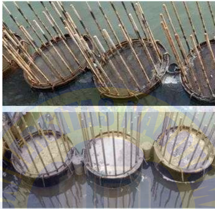
Gambar 4.15. Pancang Dan Clutch Yang Sudah Terisi Beton
