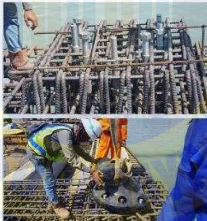
Gambar 4.37. Pemasangan Bollard
