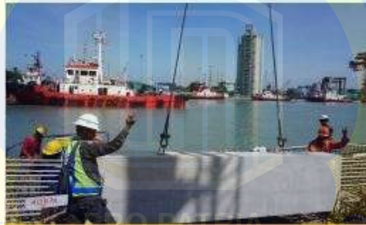
Gambar 4.32. Pemasangan Balok Precast
