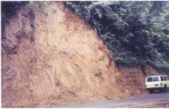
Gambar 6. Memotong lereng menjadi tegak
