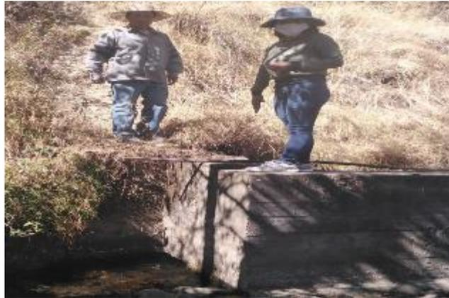
1. En la imagen observamos la captación existente en buen estado, es por eso que no necesita mantenimiento. Asimismo, se hizo la inspección con el presidente de riego.
