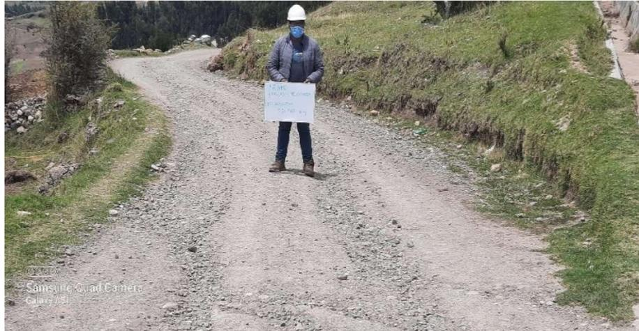
**Imagen 5** Desprendimiento de agregado Prog. 0+420 KM
