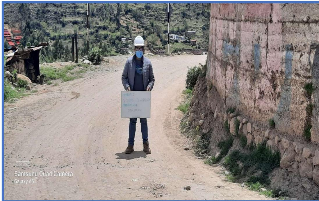
**Fotografía 03:** Presencia de baches en la progresiva 0+450 km
