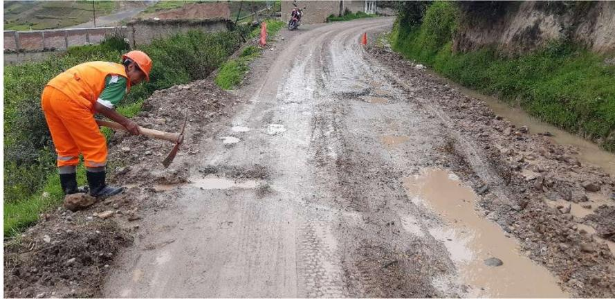
**Imagen 2** Baches debido a las precipitaciones pluviales
