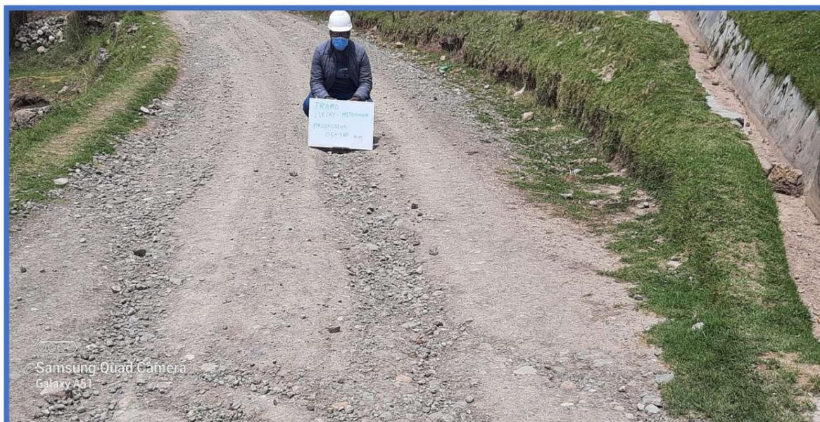
**Fotografía 05:** Presencia de ahuellamiento y desprendimiento de agregado en la progresiva 5+960 km
