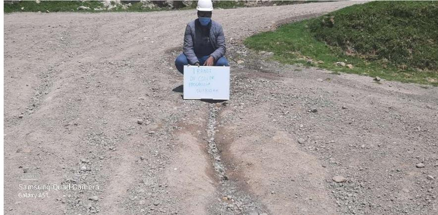
**Imagen 7** Encalaminado y Desp. de agregado Prog. 0+000
