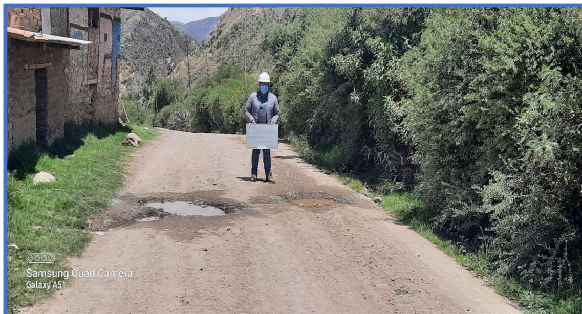
**Fotografía 04:** Presencia de baches en la progresiva 2+000 km
