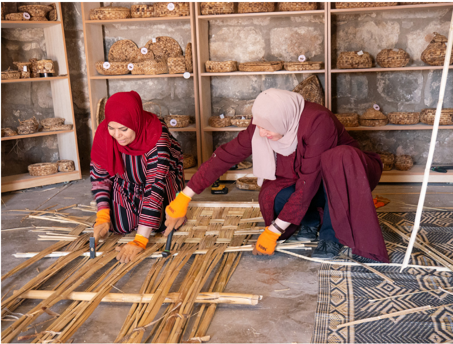
8 Umm Qays/Hara Foqa, Jordanien. Bauwerkserhaltung als Trainingsprogramm. Herstellung der Flechtmatten für die Rekonstruktion der historischen Dachkonstruktion der Madafeh, Oktober 2021. (Foto: Olga Zenker)
