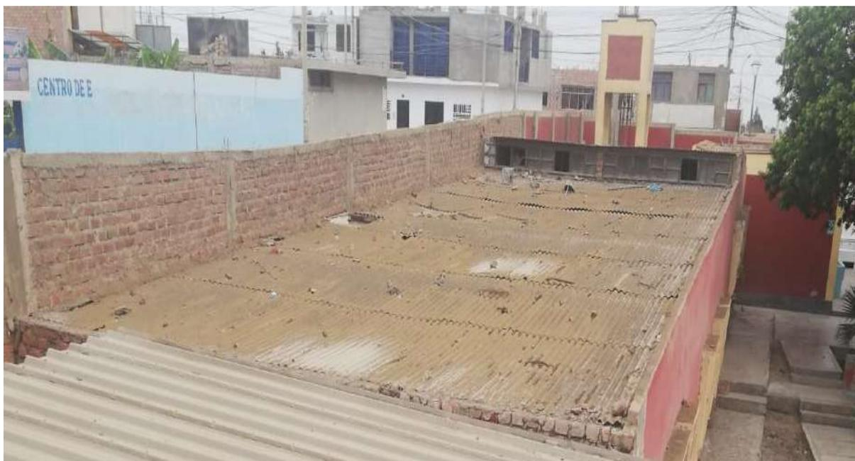
Figura 20. Cobertura dañada en el taller de trabajos manuales.
