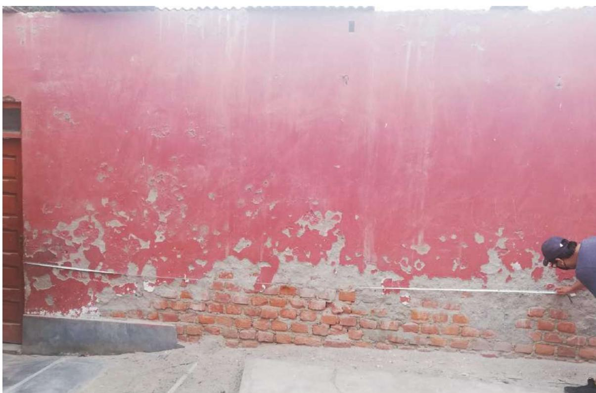
Figura 21. Descascaramiento de muro por salitre en el taller de trabajos manuales.
