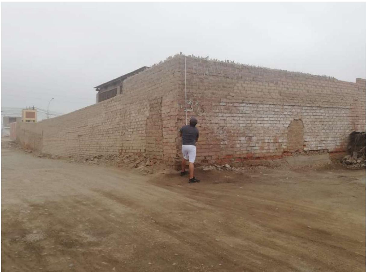
Figura 11. Medición exterior de altura máxima de muro en cerco perimétrico.
