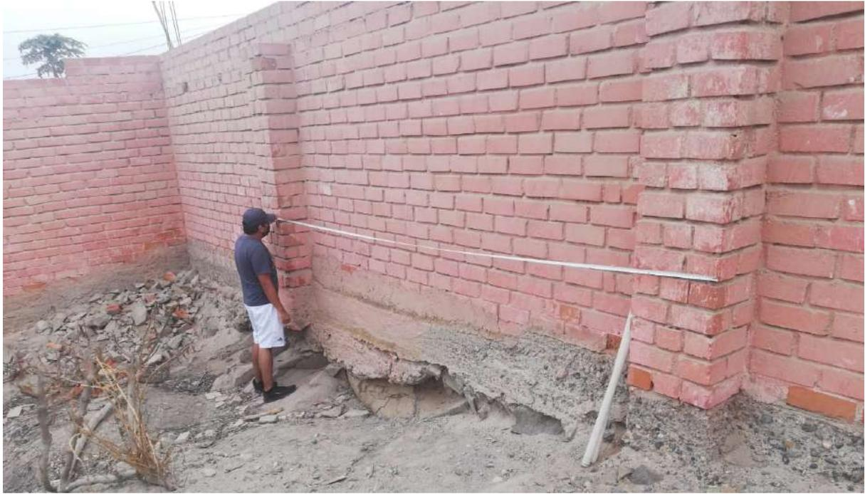
Figura 14. Medición de longitud entre columnas de ladrillo en cerco perimétrico.
