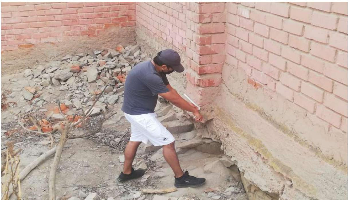
Figura 13. Medición de socavación de cimentación en cerco perimétrico.
