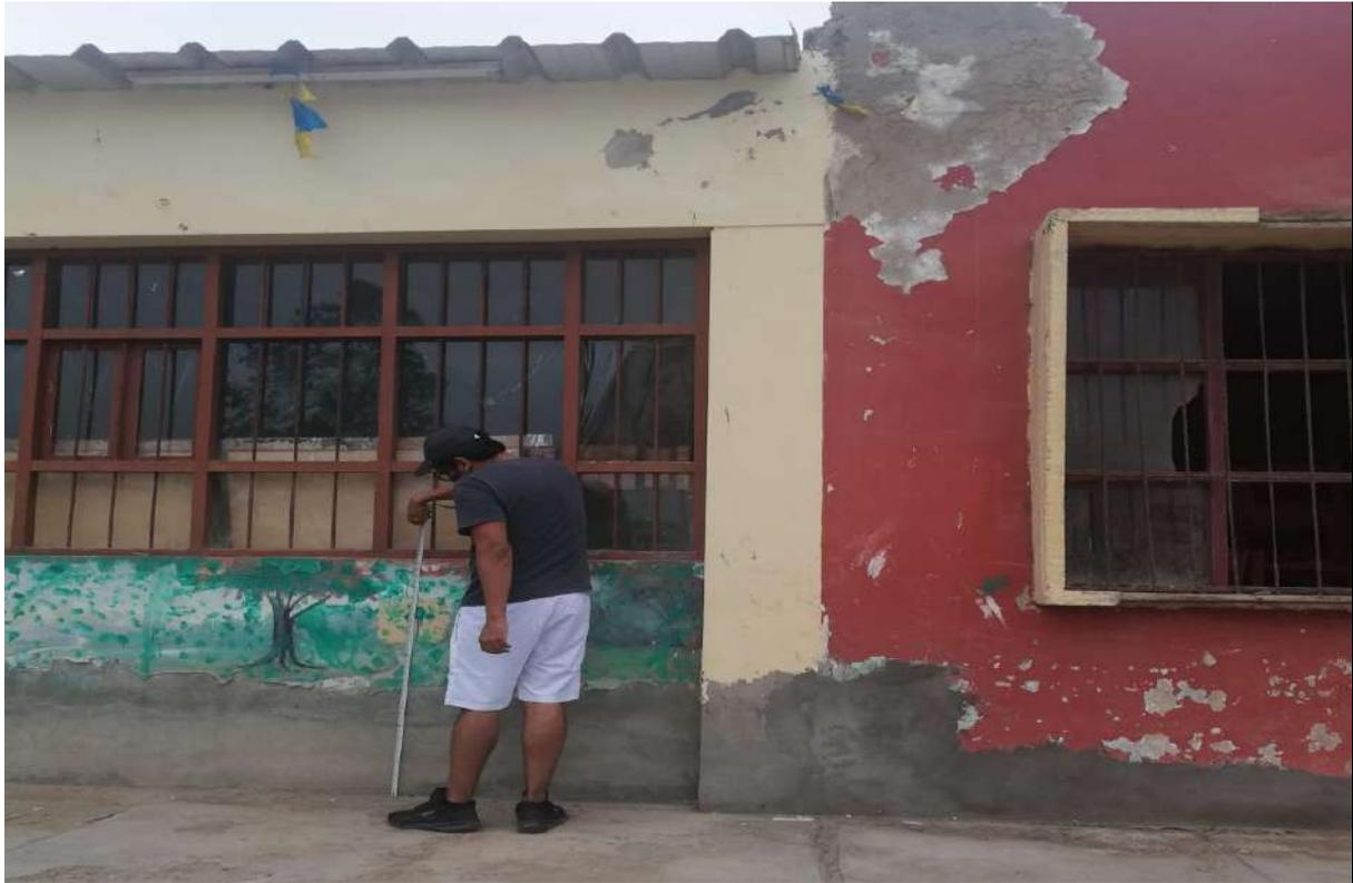
Figura 18. Medición de salitre extendido en pabellón de inicial.
