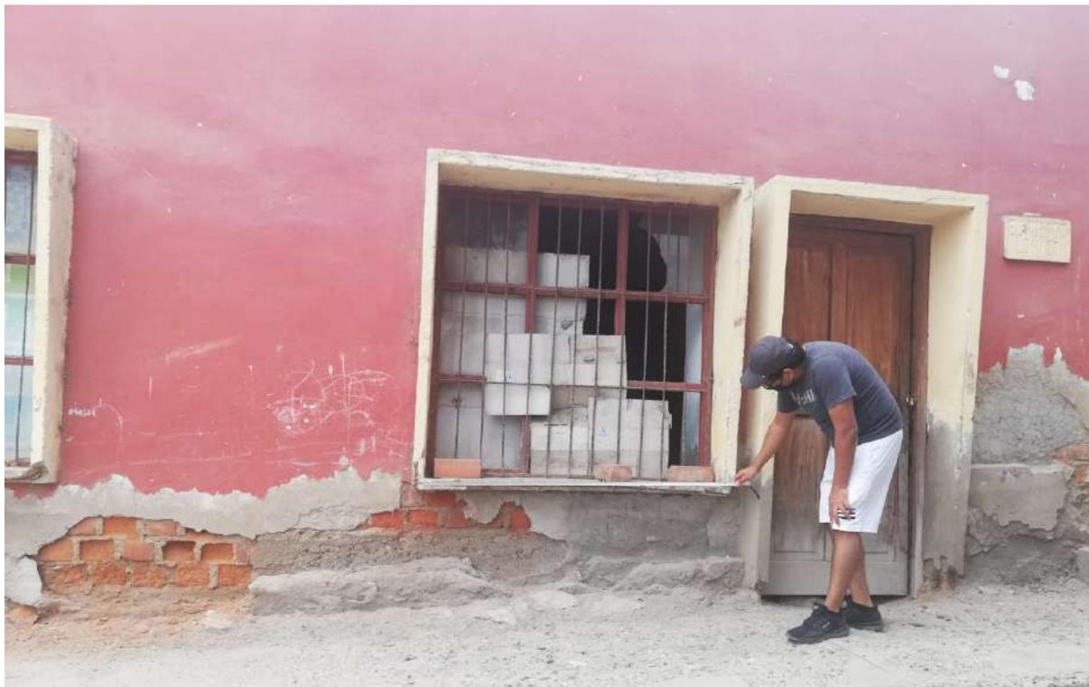
Figura 22. Medición de falla vertical de muro en taller de trabajos manuales.
