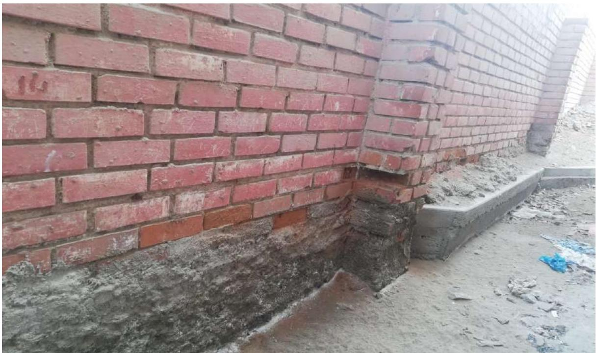
Figura 15. Cimentación de cerco perimétrico con patología.
