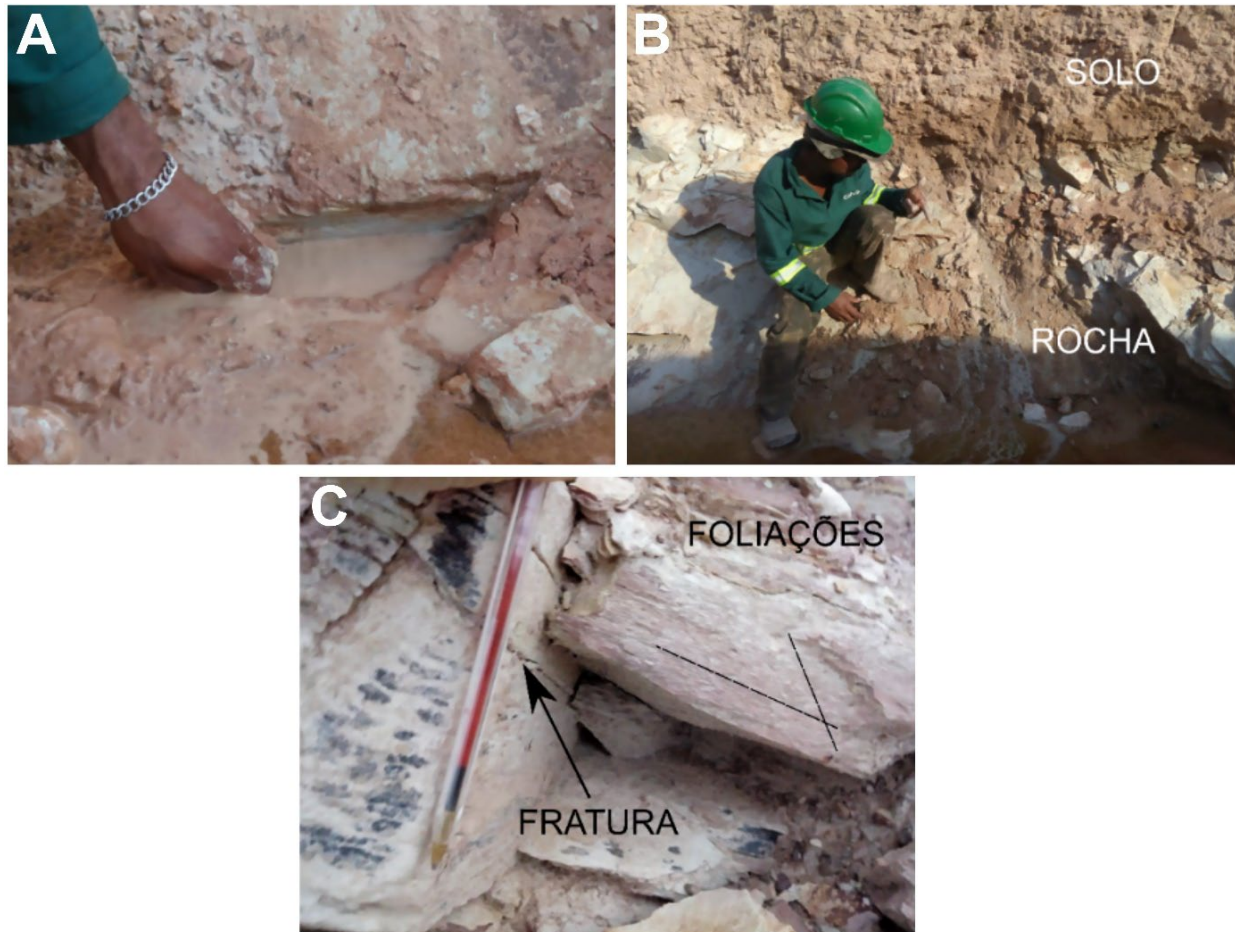
Figura 5. (A) Surgência de água subterrânea nos planos de foliação da rocha; (B) Interface do solo com a rocha (filito); (C) Estruturas na rocha (foliações e fraturas), direção e ângulo de mergulho das estruturas no filito.
