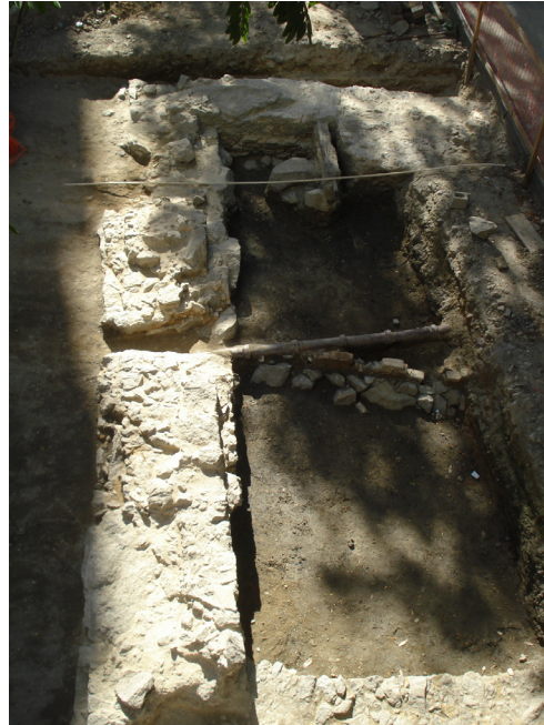
Figuras 40 e 41 – Alicerces da fachada do Trapiche da Pedra do Sal: paredes dianteiras e internas dos lotes nº 68 e 70. Fotos: Andrea Jundi.
