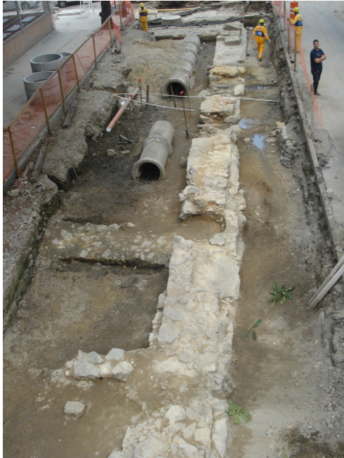
Figuras 40 e 41 – Alicerces da fachada do Trapiche da Pedra do Sal: paredes dianteiras e internas dos lotes nº 68 e 70. Fotos: Andrea Jundi.
