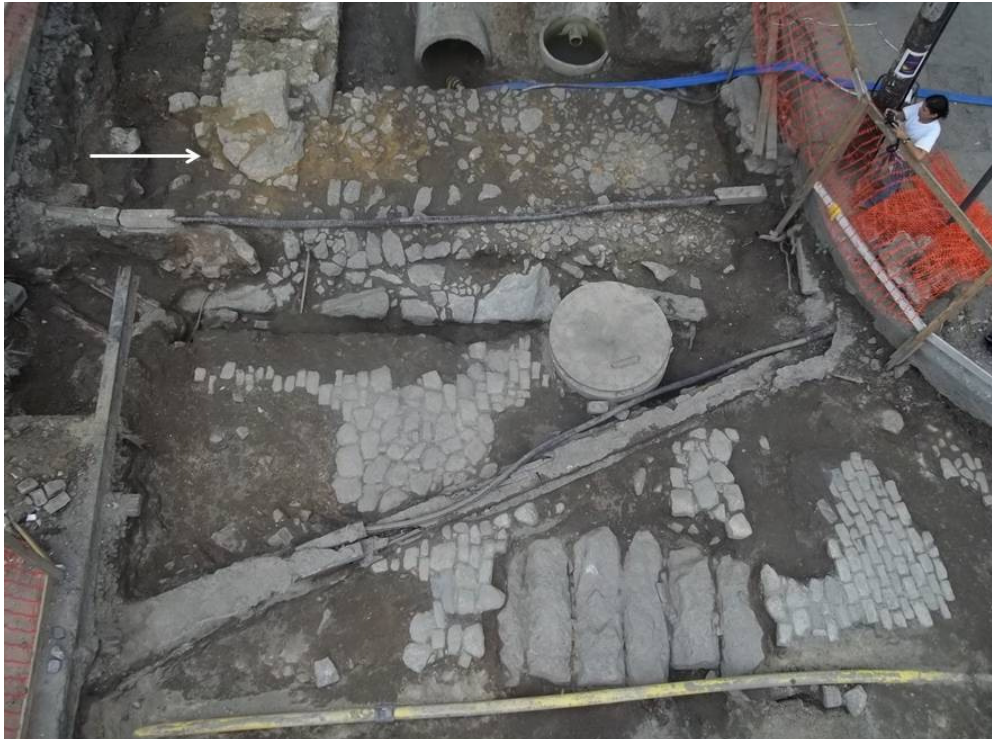
Figura 38 – Adjacentes aos antigos calçamentos do Beco da Pedra do Sal, podem ser vistos os alicerces da fachada lateral e dianteira do lote nº 68, bem como o cunhal curvilíneo (assinalado com uma seta) que atesta sua localização em uma esquina, antes da ampliação. Foto: Andrea Jundi.
