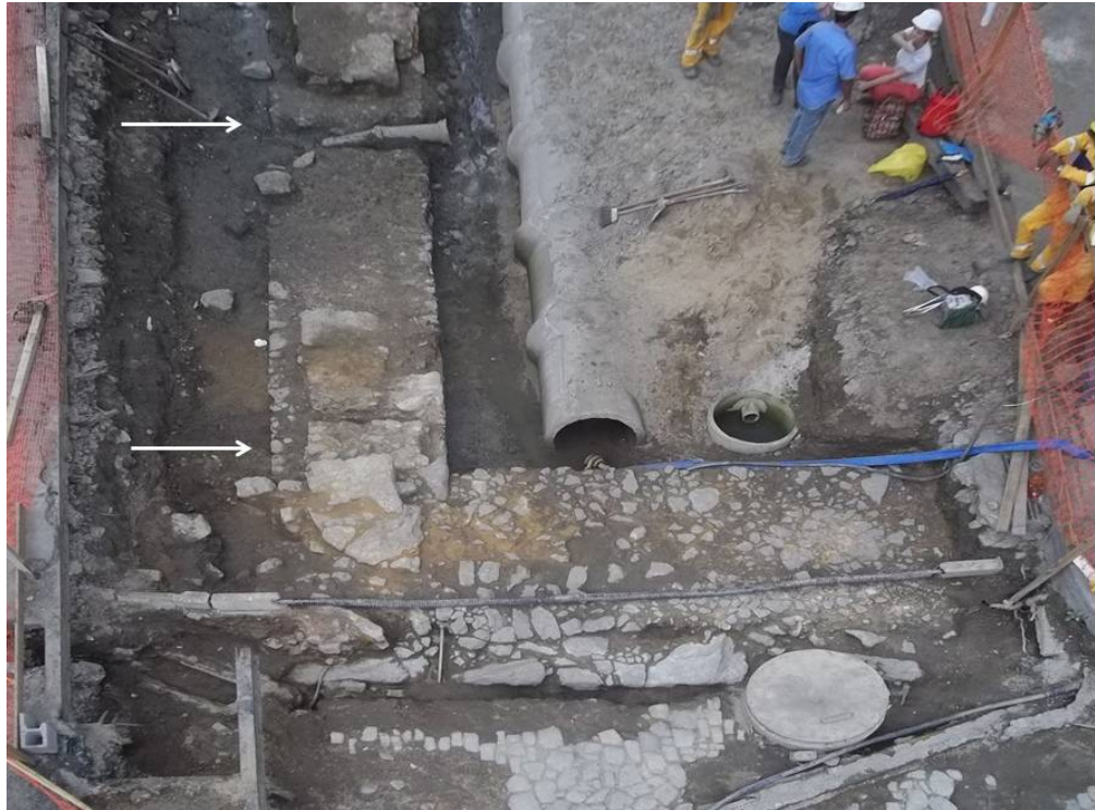
Figura 39 – Delimitação do vão de 4,0 m de extensão para entrada de cargas de grandes dimensões. Foto: Andrea Jundi.
