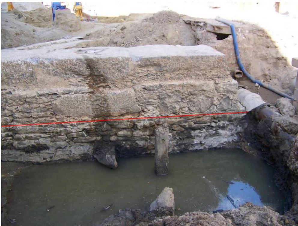
Figura 7 – O píer de alvenaria de pedra exposto com as escavações (lateral voltada para a Avenida Barão de Tefé). No nível inferior, observa-se a primeira etapa, bem como o esteio de madeira que provavelmente sustentava um tabuado à época. Foto: Sílvia Puccioni.
