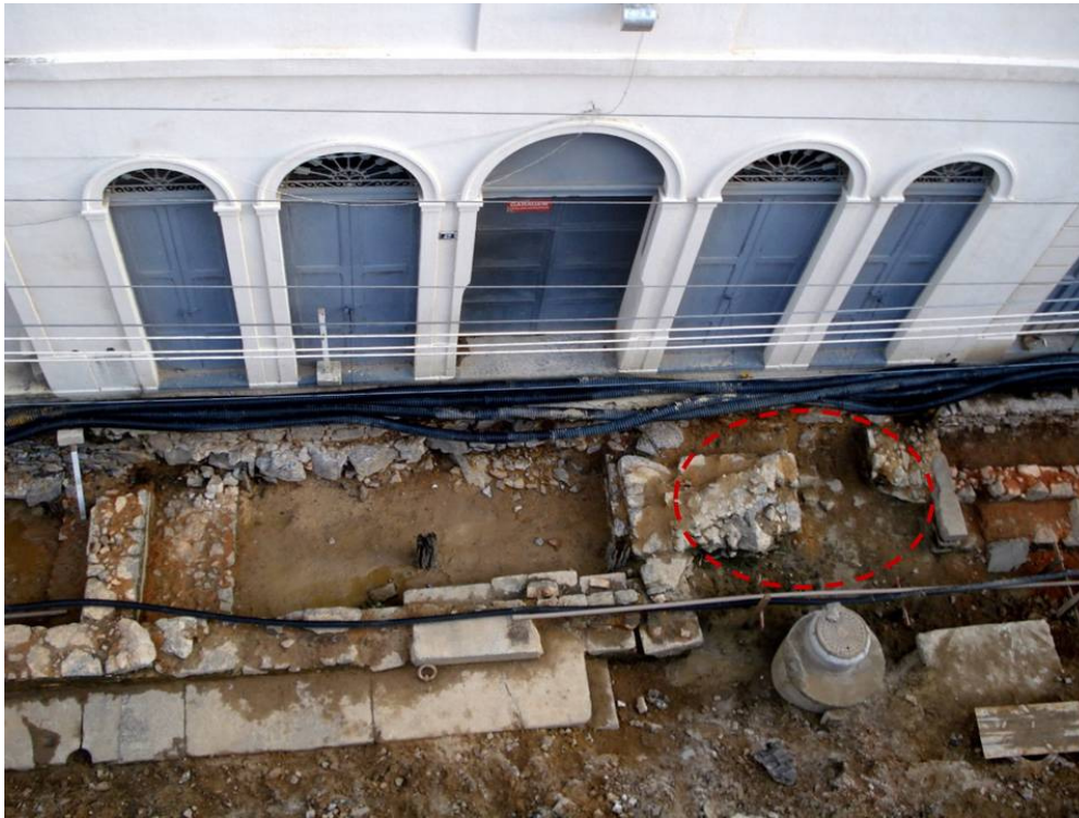
Figura 15 – A área de transição entre os trapiches, com bloco retangular de alvenaria robusta, uma possível base de apoio para o equipamento destinado a içar cargas. Foto: Studio Soma.
