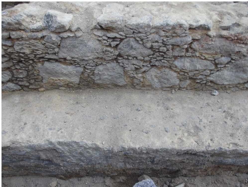
Figura 32 – Reforço da alvenaria dos pilares com uma linha de pedras para nivelamento e contenção de esforços transversais dos maciços murários, devido à grande dimensão desta edificação. Foto: Andrea Jundi.
