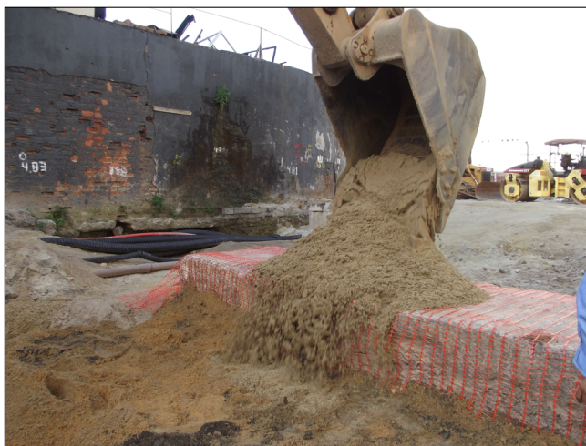
Figura 19 – O píer principal, sinalizado por tela tapume e protegido por uma camada de areia, e a rua novamente asfaltada. Foto: Andrea Jundi.
