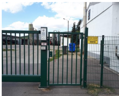
Abbildung 8: Beispiel für einen vorbildlichen Verschluss des Betriebes
