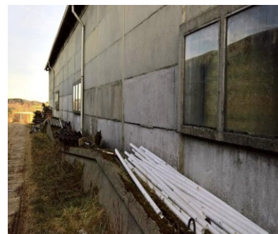
Abbildung 9: Beispiel für ordentliche Außenanlagen
