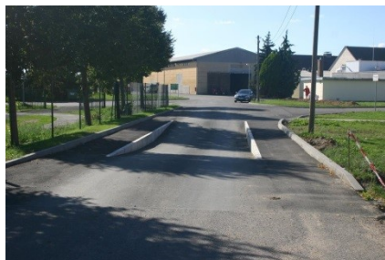
Abbildung 34: Beispiel für die Einzäunung und den Verschluss des Betriebes mit maßgehaener Desinfektionsdurchfahrwanne
