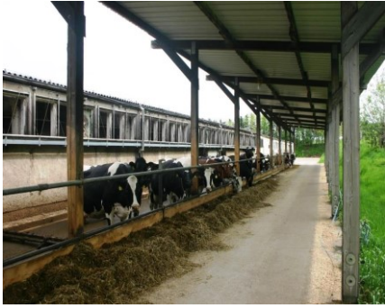
Abbildung 81: Auslauf mit Betonfußboden, per Schieber gereinigt
