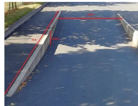
Abbildung 35: Maße der Desinfektionsdurchfahrwanne von Abbildung 34. Länge 15 Meter, Tiefe 0,45 Meter und Breite 3,52 Meter
