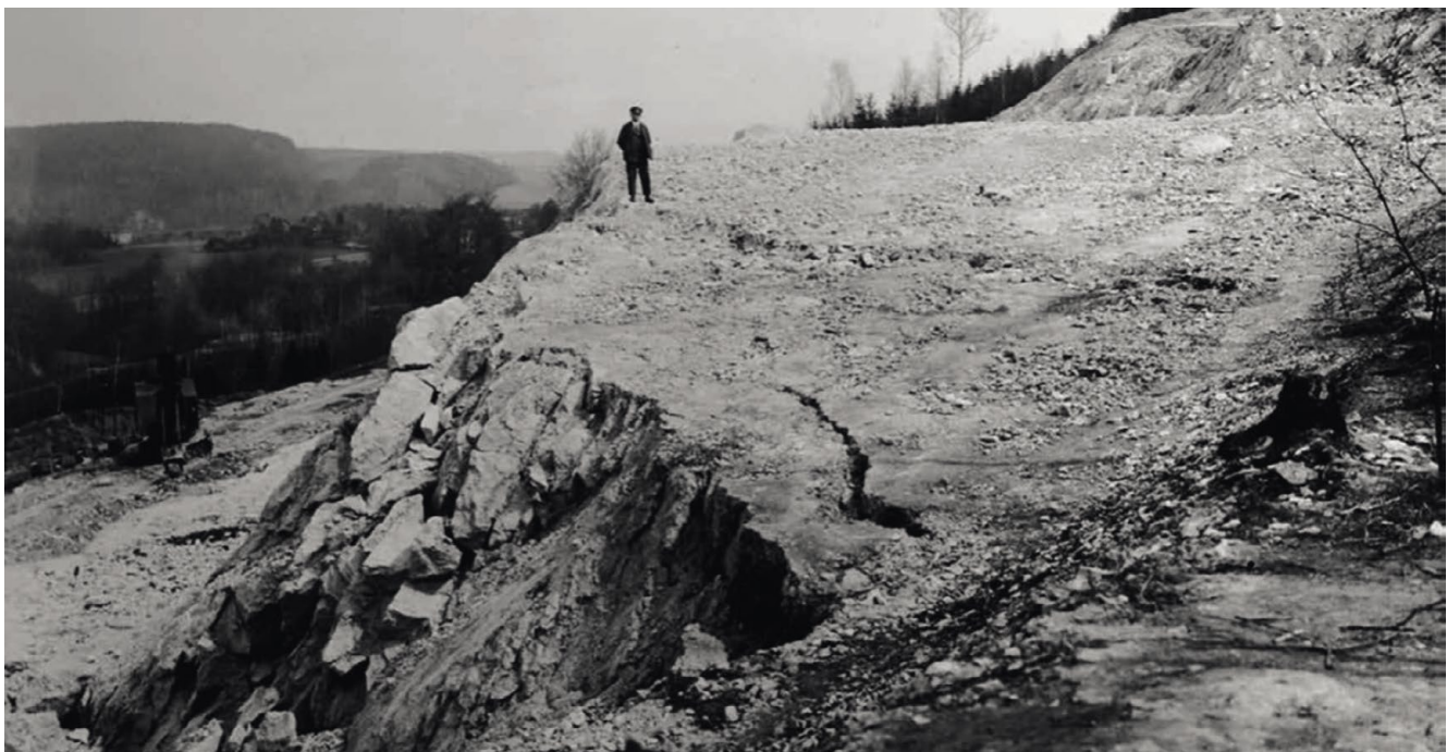
Abbildung 3: Blick vom oberen Westrand der Baustelle nach Osten.
