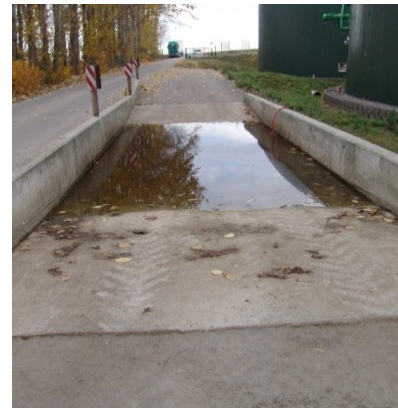
Abbildung 6: Desinfektionsdurchfahrwanne in ausreichender Länge
