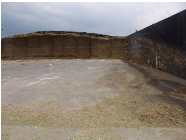
Abbildung 7: Kontrolle des baulichen und hygienischen Zustands des Silos
