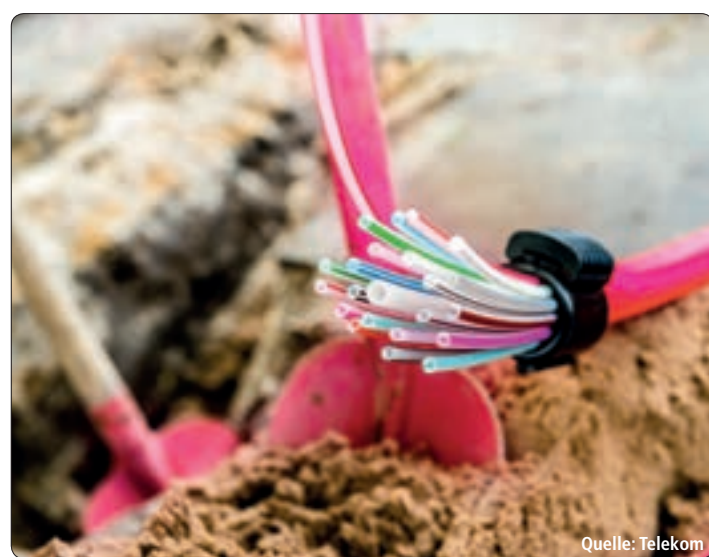
Für rund 19.000 Haushalte in Zwickau baut die Telekom ihr Glasfasernetz aus.
