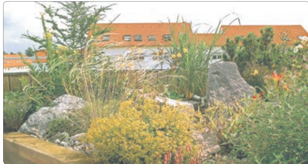
Bei einer intensiven Begrünung lassen sich auf dem Dach gute Wachstumsbedingungen schaffen. Foto: djd/Paul Bauder
