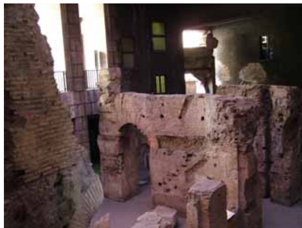
Fig. 2 - Roma, piazza Navona 48-52: sotterraneo con strutture dello stadio (foto dell'autrice).
