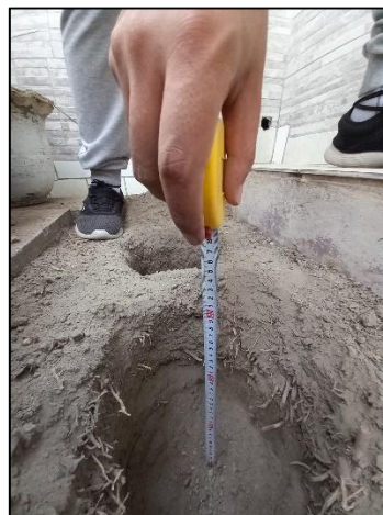
Figura 16. Profundidad excavada destinada a las urnas biodegradables
