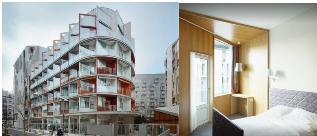
Figura 32: Vista exterior /vista interior (dormitorio) del “Hogar de ancianos/ atelier du Pont”.
