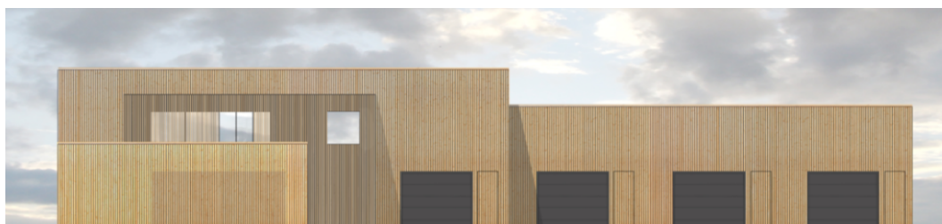
Figur 5.1: Modalen sitt nye kontor- og lagerbygg [72]
