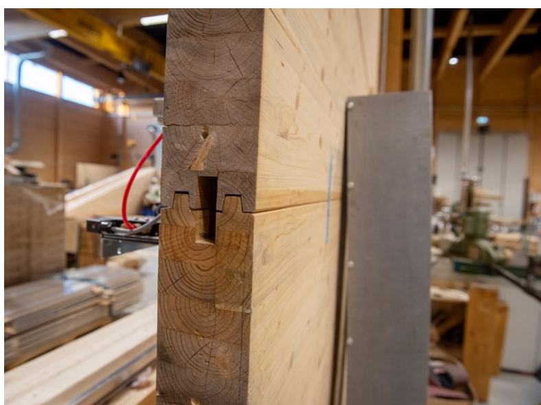
(a) Tverrsnitt av sammensatte HBE-elementer [41]
