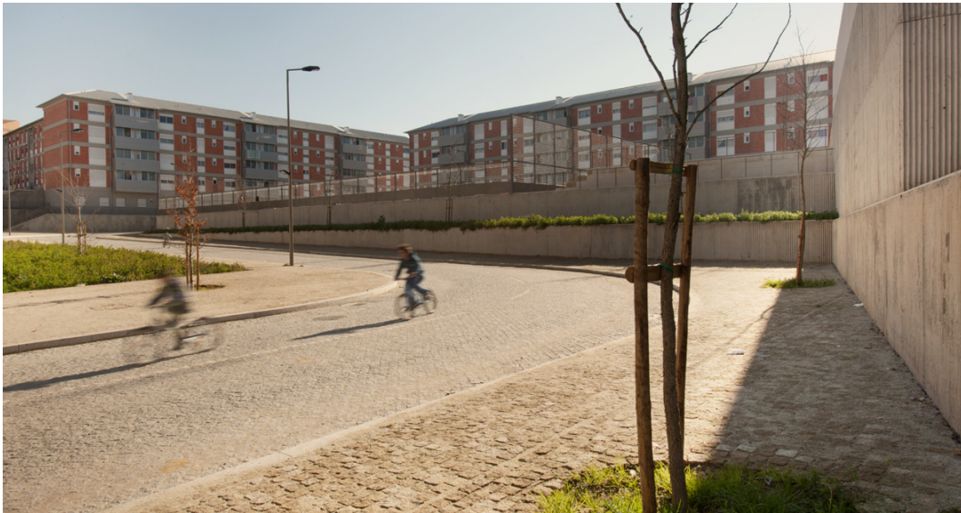
Fig. 4 The new road in Lagarteiro (foto by Inês d'Orey).
