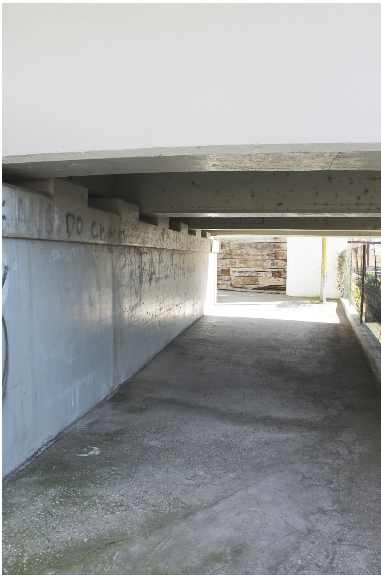
Figura 57– Espaço inferior ao viaduto, Vila Nova da Rainha, 2018
