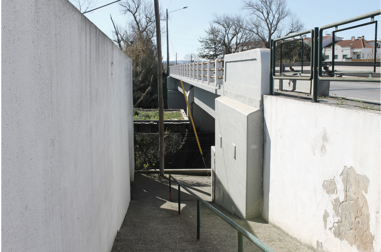
Figura 55 – Espaço inferior ao viaduto, Vila Nova da Rainha, 2018
