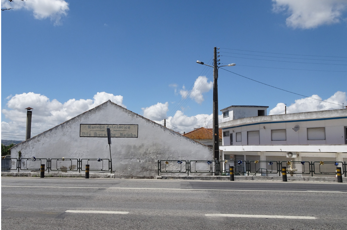
Figura 58 – Consequência da passagem do viaduto no edifício do rancho, Vila Nova da Rainha, 2018
