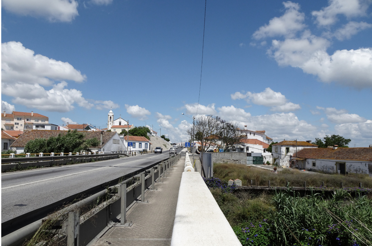
Figura 50 – Vista Superior do Viaduto da Estrada Nacional 3, 2018
