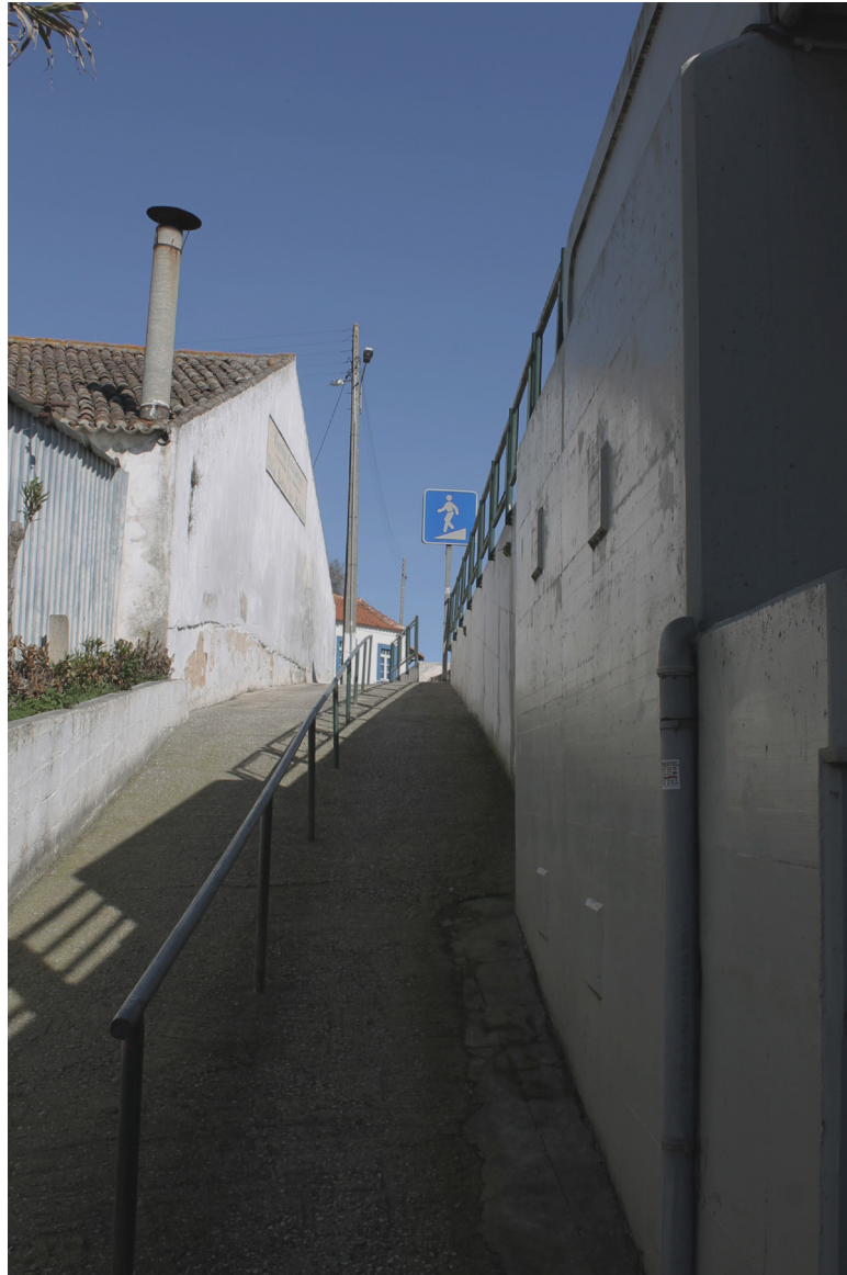
Figura 56 – Rampa de acesso ao espaço inferior ao viaduto, Vila Nova da Rainha, 2018
