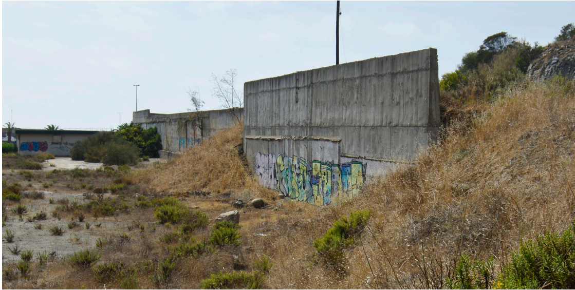
Fig.50 Fotografia do Muro Pré-existente
