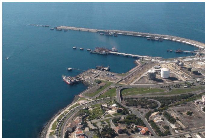
Fig.27 TPQ- Terminal Petroquímico
