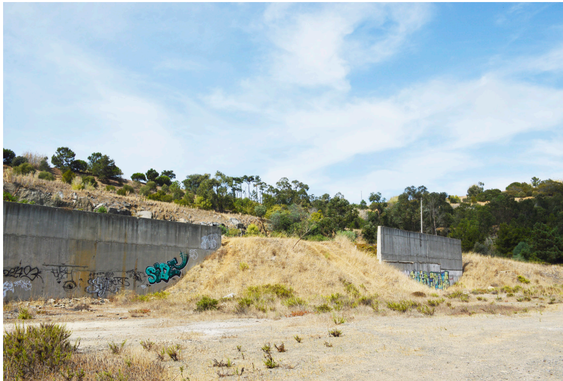
Fig.49 Local de Intervenção
