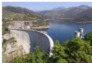
Alto do Lindoso Dam, Portugal (€369 Mn)
