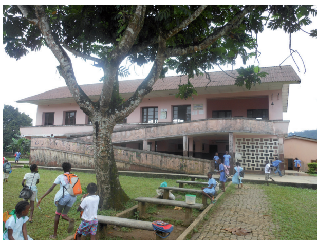
Figura 13 - Escola Primária de São João dos Angolares, São Tomé, engenheiro-chefe A. Ferreira?, 1960-1962
