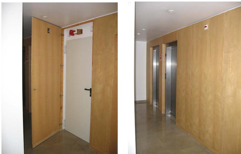
Figura 7.14 – Acesso a instalações e equipamentos em zonas comuns dissimulado por painel
