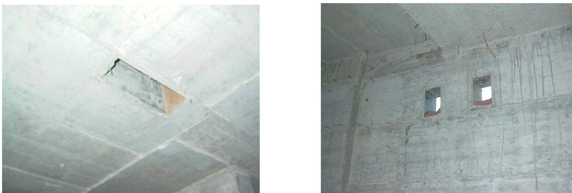
**Figura 4.7 – Exemplos de negativos definidos para laje de betão (esquerda) e parede resistente em betão (direita)**
