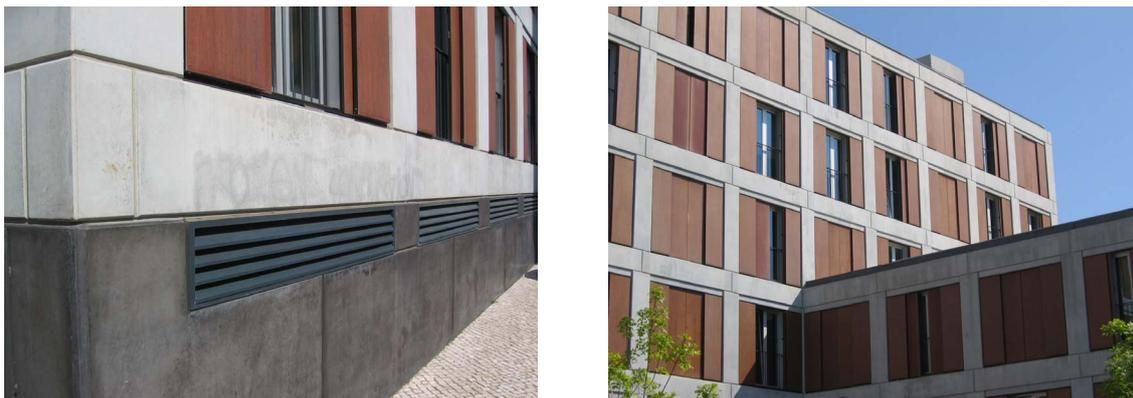
**Figura 7.16 – Grelhas de ventilação integradas com a fachada (esq.) e caixa de elevador dissimulada por vãos falsos e saliente na cobertura**
