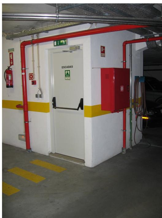
Figura 7.12 – Instalações e equipamentos de segurança contra incêndio em caves de estacionamento
