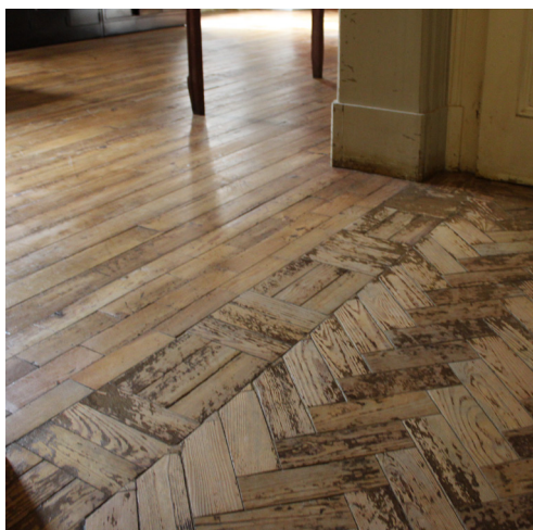
Imagem 33- passagem do pavimento de tacos para soalho, existente no conservatório. (fonte própria)
