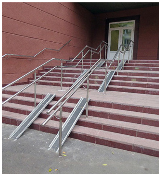
Imagem 4 – Acesso adaptado – introdução improvisada de rampas disfuncionais numa escadaria de acesso a um edifício público; Acesso inclusivo – Escadaria/rampa pensada e desenhadas antes da execução do projeto.
