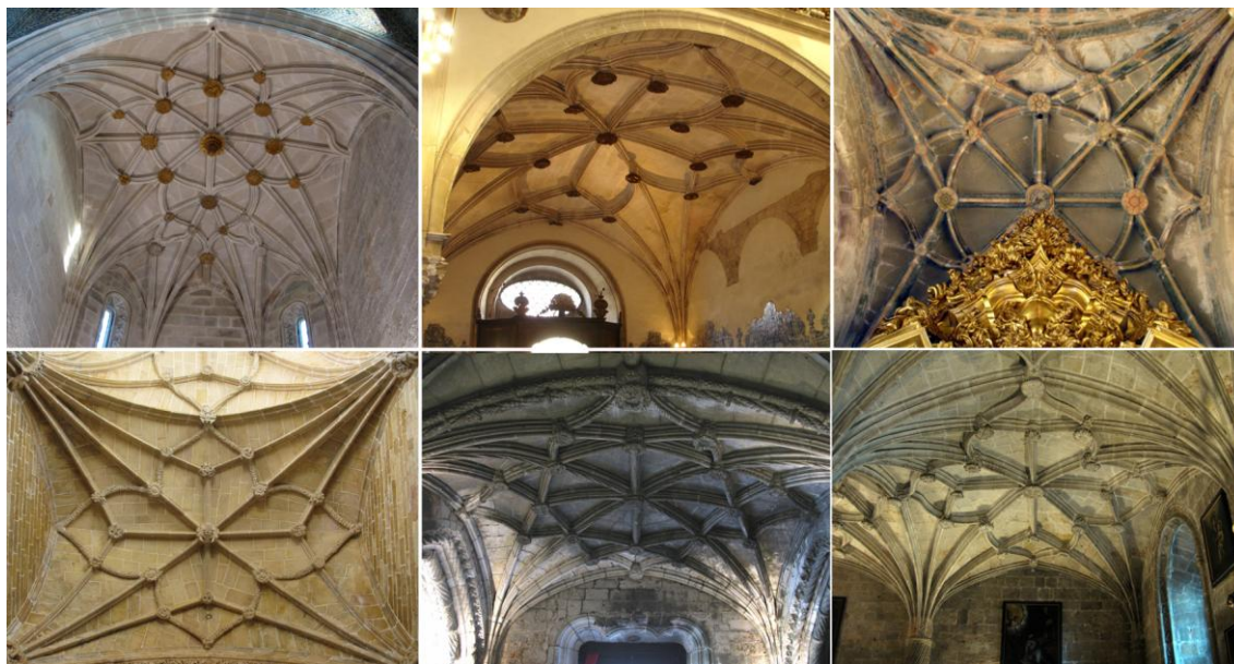
Fig. 3 – Abóbadas de combados portuguesas com forma de arcos conopiais: capela-mor da igreja de Caminha (a), sub-coro da igreja do convento de Santa Cruz de Coimbra (b), capela dos Carneiros do convento de S. Francisco no Porto (c), igreja do Convento de Cristo em Tomar (d), sub-coro e sacristia do mosteiro dos Jerónimos em Lisboa (e,f),
