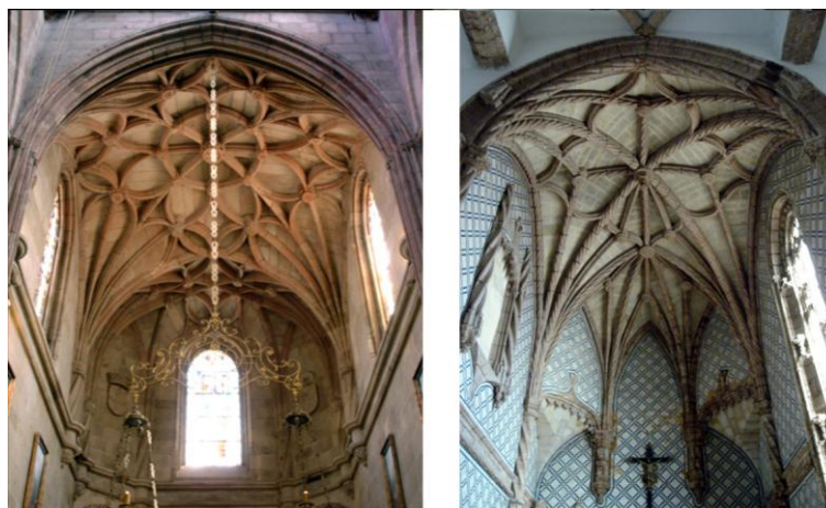
Fig. 1 – Abóbada da capela-mor da Sé de Braga (esquerda) e abóbada da capela-mor da igreja do convento de Jesus, em Setúbal (direita).
