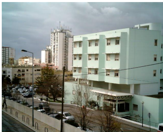
Figura 21 – Imagem do lado nascente do Hospital de Setúbal. É bem visível a pressão urbana envolvente, e a limitação de espaço.
