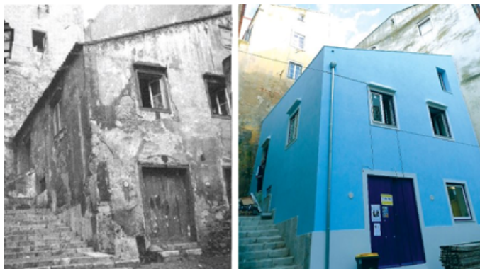
Fig. 4: Edifício devoluto antes da implementação de entre-usos; e Fig. 5: Sede da Associação Renovar a Mouraria em Lisboa (Fonte: Boas Notícias, 2012).
