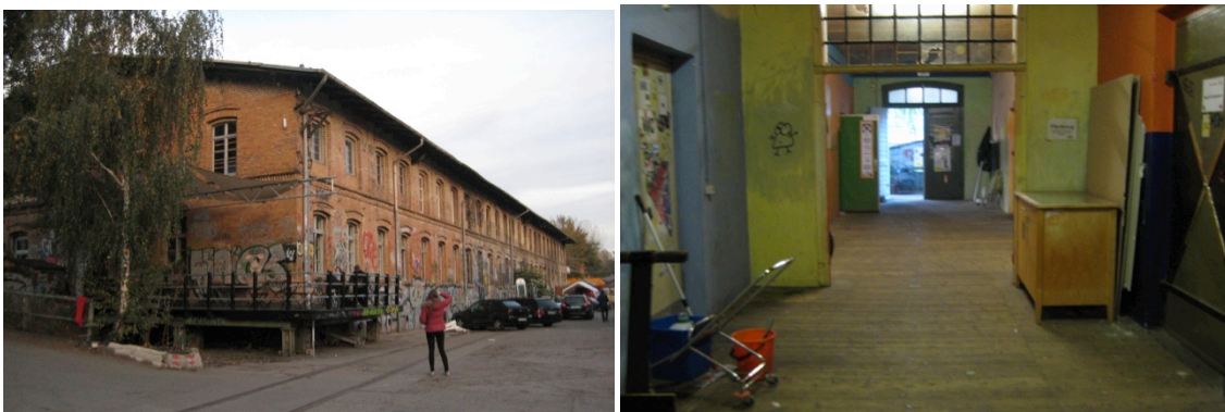
Fig. 36 e 37: Edifício dos projetos associados à RAW-Tempel, 2014 (Fotografias: MM)
