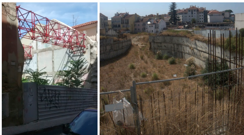
Fig. 92: Lote vago em decorrência de demolição; e Fig. 93: Lote vago à espera de construção, 2014 (Fotografia: MM)
