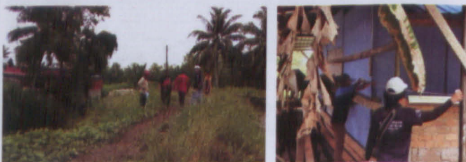
Initial site works at Kampung Tebelu, Sebuyau, Sarawak
