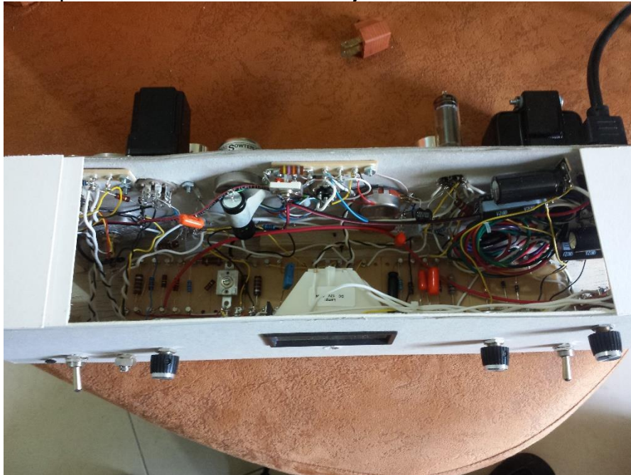
Fuente: Foto realizada por el autor.
