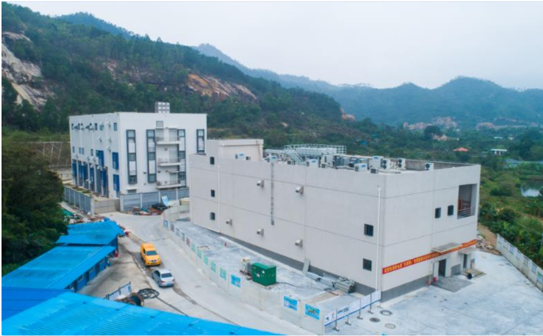
Figura 24 Primer Proyecto de demostración de energía inteligente aprobado por la Administración Nacional de Energía (NEA) "Internet Plus" City-Park de doble nivel de China, ubicado en Zhuhai, provincia de Guangdong, China. [41]
