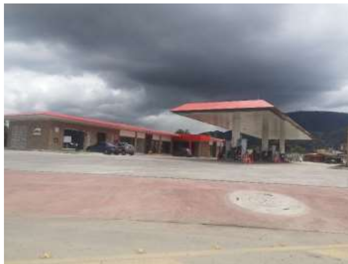
Fotografía 3. Estación de servicio
