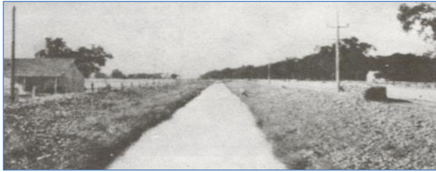
Ilustración 20 Canal excavado en manga arcillosa y limosa. Lecho duro y resbaladizo, n= 0,024.
