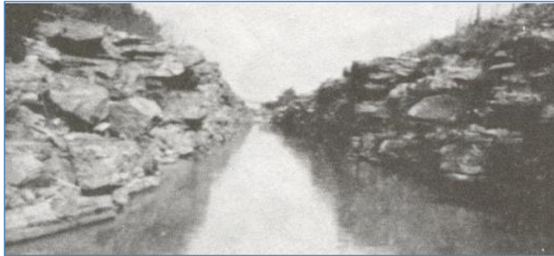
Ilustración 24 Canal en roca excavado con explosivos, n= 0,040.
