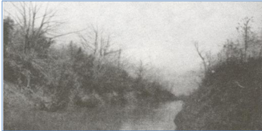
Ilustración 26 Canal dragado, pendientes laterales y fondo irregulares; en arcilla negra plástica en la parte superior hasta la arcilla amarilla en el fondo, lados cubiertos con pequeños matorrales y arbustos, n= 0,045.
