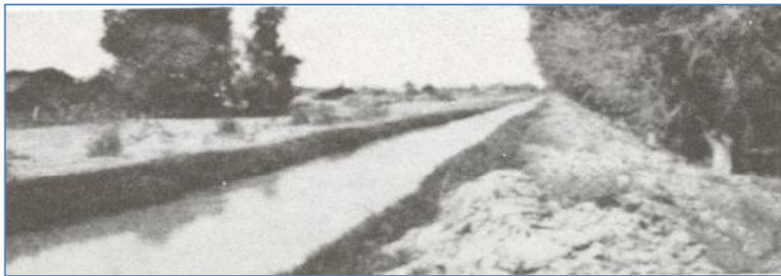
Ilustración 21 Canal en tierra excavado en un suelo de limo aluvial, con depósitos de arena en el fondo y crecimientos de pastos, n= 0,029.
