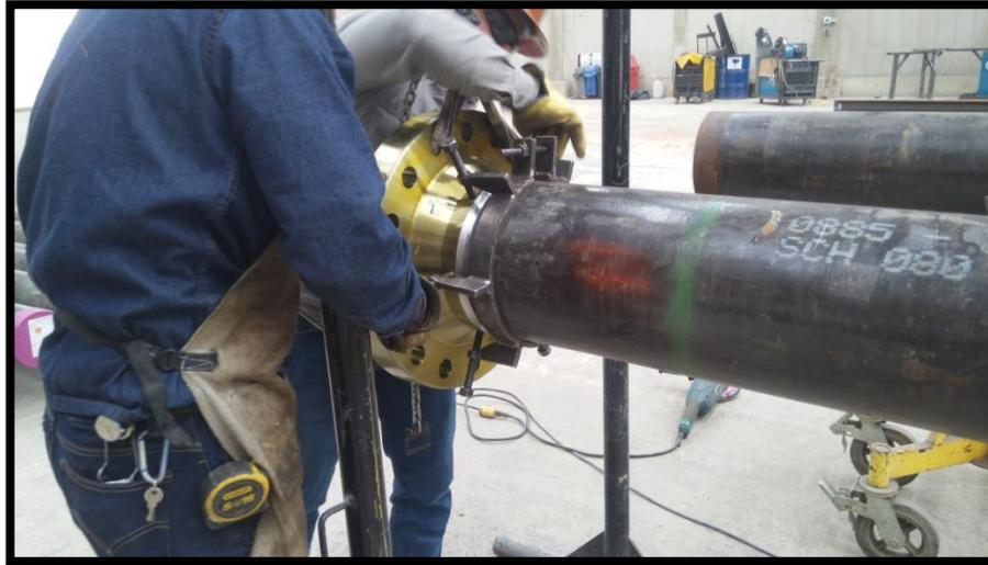
Se puede ver como se realiza el proceso de armado y alineación de una junta brida – tubo de 10 “
