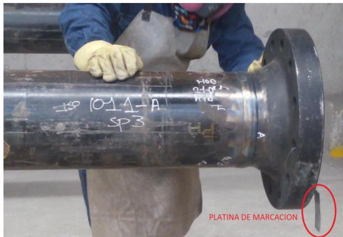
*Ilustración 67. Platina de marcación (después)*
