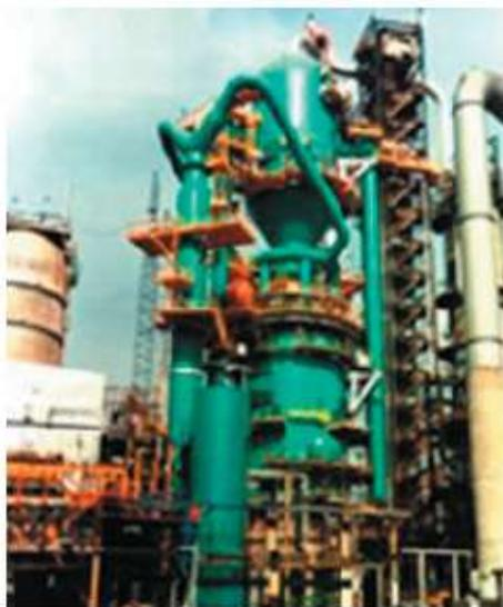
Figura 6.8: Unidade de FCC com Duplo *Riser* Externo na REPLAN
