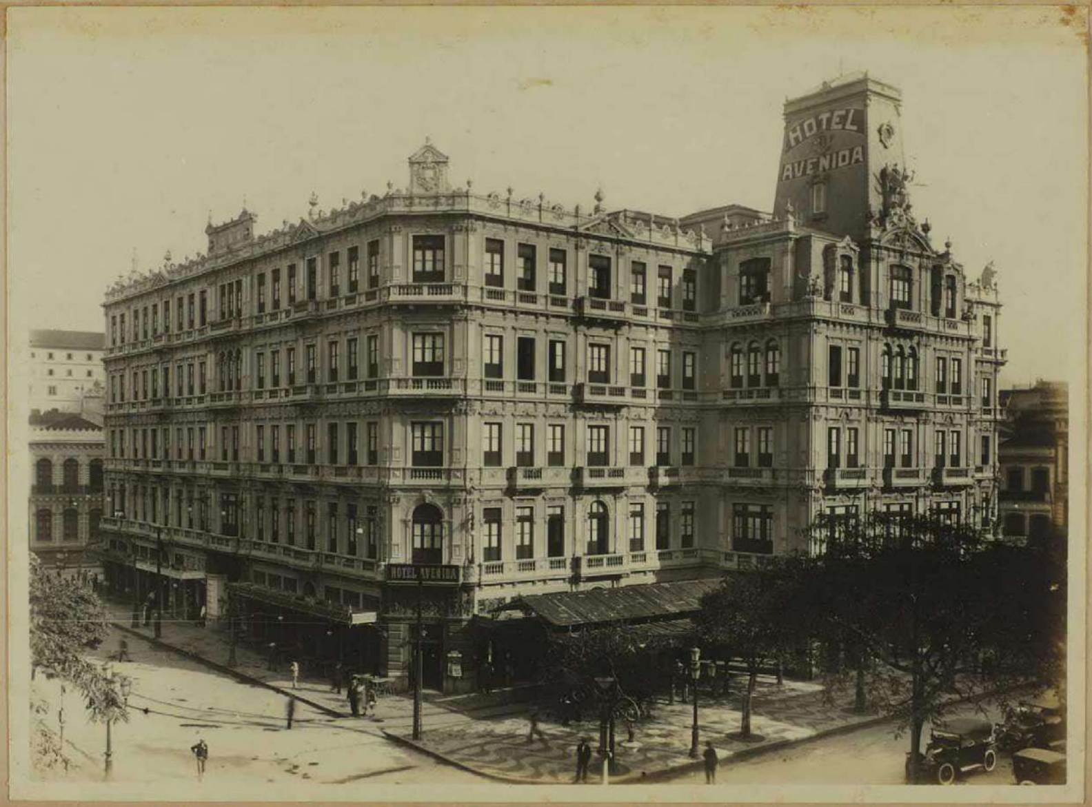
Figura 19 – O grande Hotel Avenida, já existente, da Companhia dos Grandes Hoteis Centraes , s.d. Fonte: Album Photographias D. Federal 1911-1920
