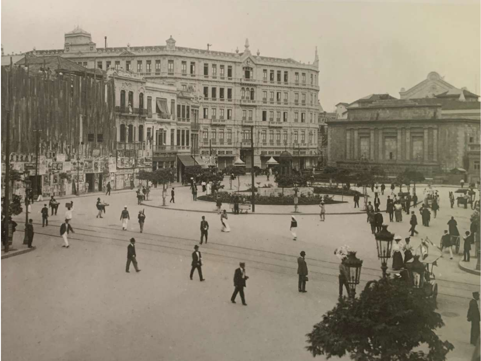
Figura 37 – Uma das alamedas da galeria dava acesso ao Largo da Carioca, para onde também se voltava uma das fachadas do Hotel Avenida Na foto, o largo e o grande hotel Avenida ao fundo, c. 1908, por Marc Ferrez À direita, o antigo chafariz projetado por Grandjean de Montigny Fonte: O Rio Antigo do fotógrafo Marc Ferrez
