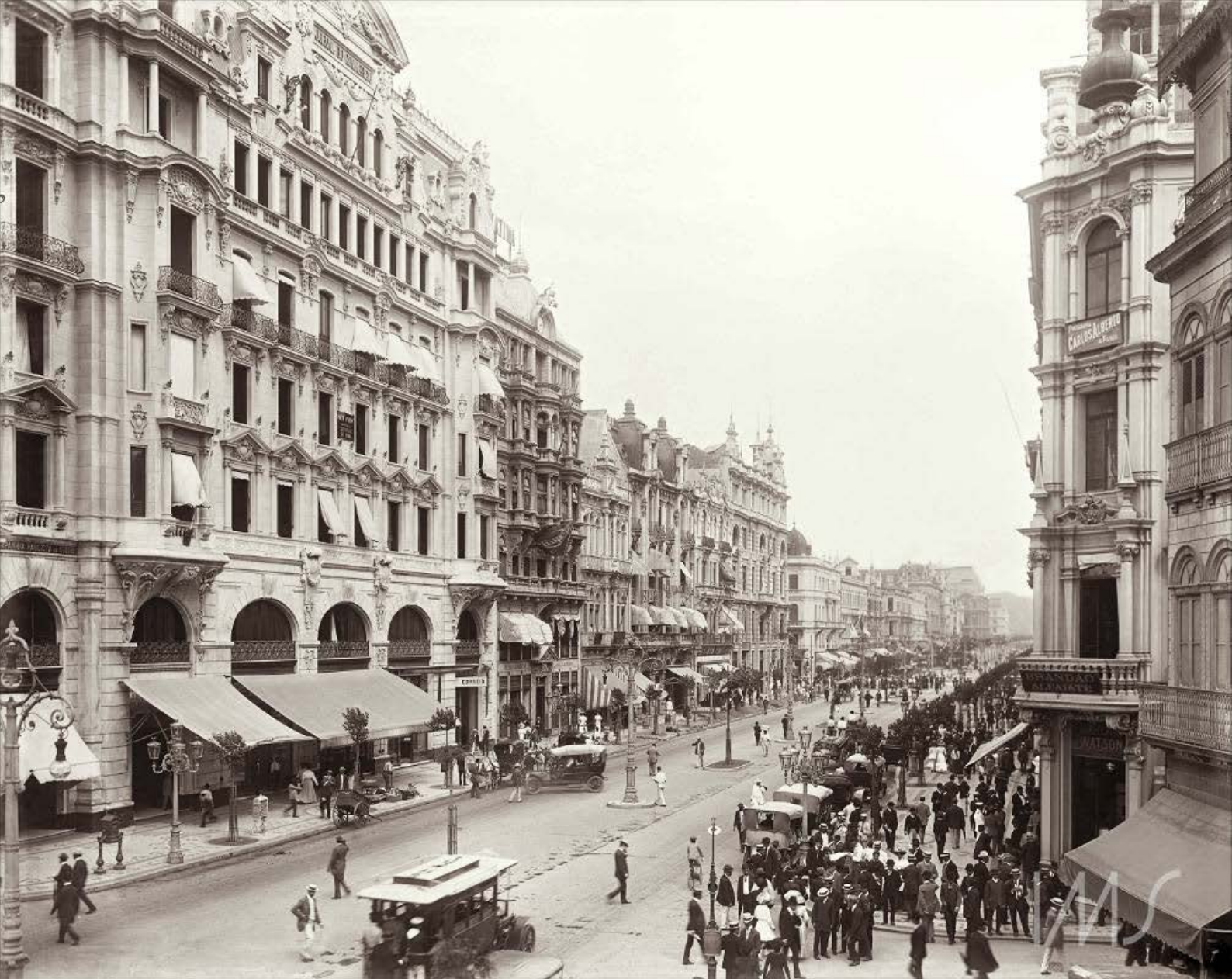
Figura 04 – Avenida Central recém-inaugurada, 1906, por Marc Ferrez Avenida na altura da Rua do Ouvidor com Rua Miguel Couto Fonte: Brasiliana Fotográfica, acervo Instituto Moreira Salles
