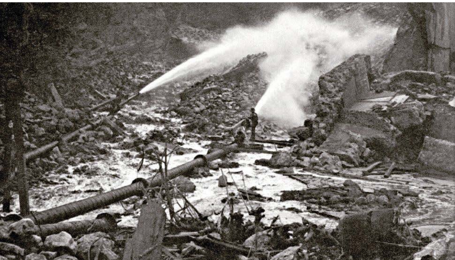
Figura 06 – Desmorte do morro do Castelo, com mangueiras hidráulicas, 1921-22, por Júlio Ferrez Fonte: O Rio do morro ao mar , Arquivo Nacional
