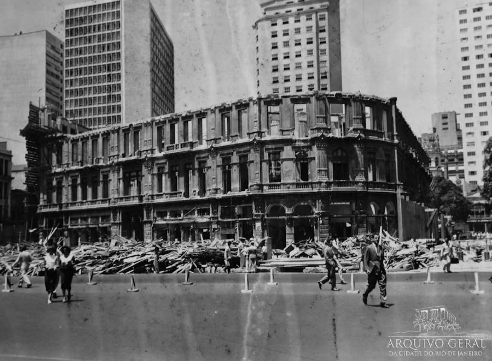
Figura 42 – Demolição do Hotel Avenida, s.d. Fonte: Arquivo Geral da Cidade do Rio de Janeiro
