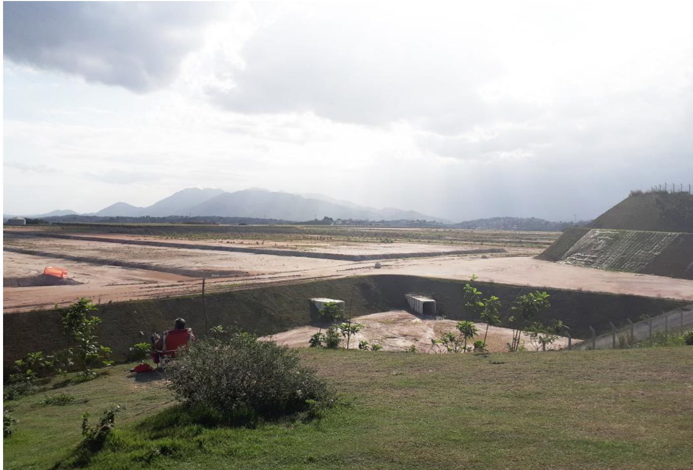
Vista da área em construção da empresa Prologis Acervo Pessoal 2019
